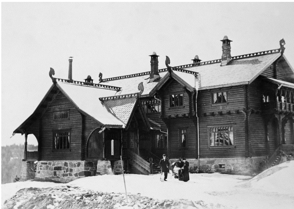
Thomas Thomassen Heftyes villa i dragestil stod ferdig i 1897, tegnet av Holm Munthe. Foto: ukjent Oslo Museum
